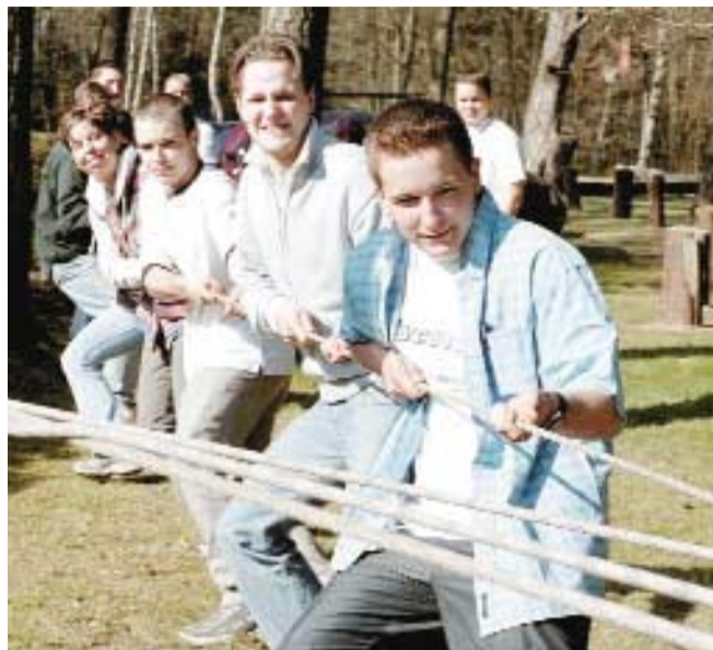
Teamarbeit war angesagt: Hier musste beim Bau einer Seilbrücke ein Tau fest um zwei Bäume gespannt werden.
